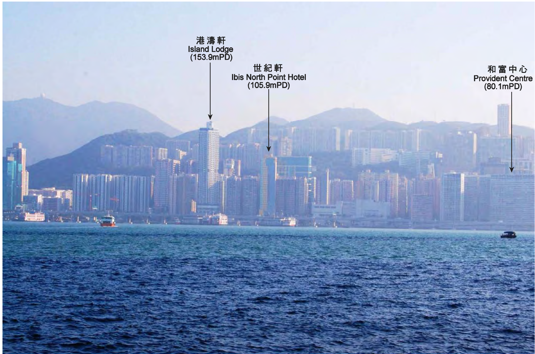
現存景觀 EXISTING VIEW
